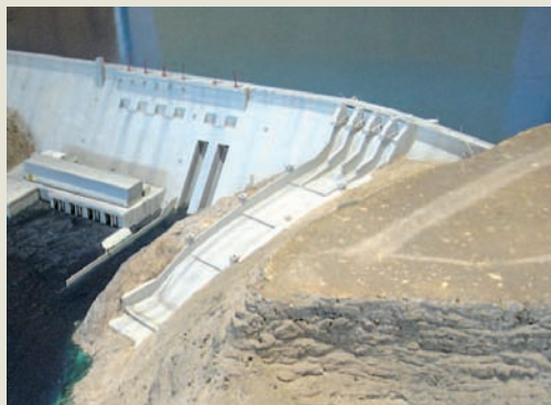
Le barrage de Piedra del Aguila et, sur la droite, la piste de secours...
